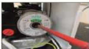
4. Используя отвертку, проверните ротор влево и вправо
