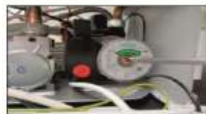
5. Закрутите обратно центральный винт (2,5 Нм) и закройте лицевую панель котла
